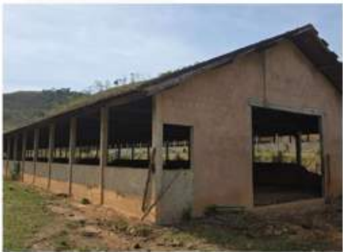
Figura 22 - Vista lateral do galpão - Gestação e cobertura. Fonte: Do autor.
