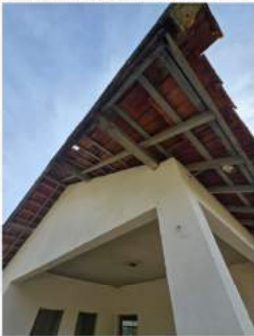
Figura 11 - Cobertura em telha cerâmica - escritório. Fonte: Do autor.
