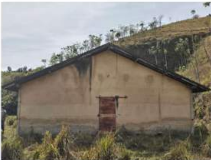
Figura 17 - Fachada do galpão de reprodução de suínos. Fonte: Do autor.
