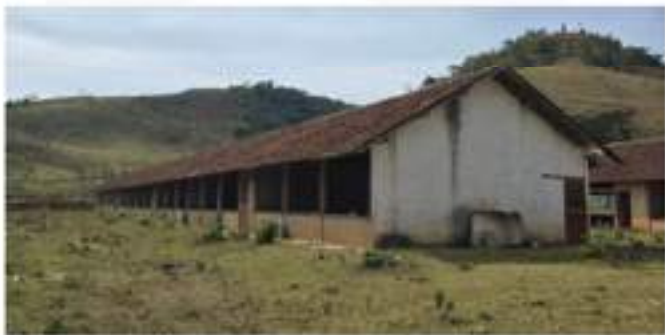
Figura 26 - Vista lateral - galpão de creche. Fonte: Do autor.
