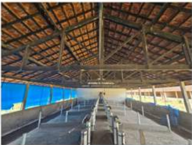
Figura 29 – Estrutura de telhado e cobertura - engorda. Fonte: Do autor.
