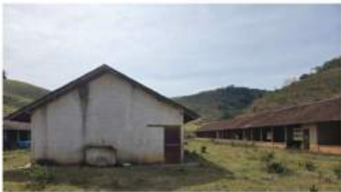
Figura 25 - Fachada - galpão de creche. Fonte: Do autor.
