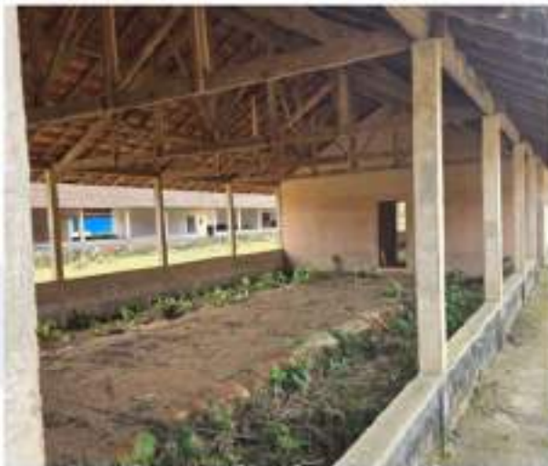
Figura 27 - Estado de conservação - creche. fonte: Do autor.
