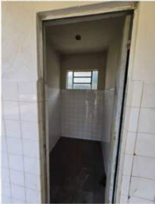
Figura 7 - Vista de um dos banheiros do escritório. Fonte: Do autor.
