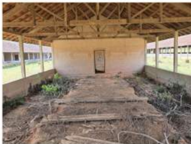
Figura 24 - Galpão de cobrição. Fonte: Do autor.
