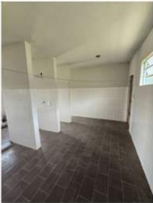
Figura 6 -Vista interna do vestiário do escritório. Fonte: Do autor.
