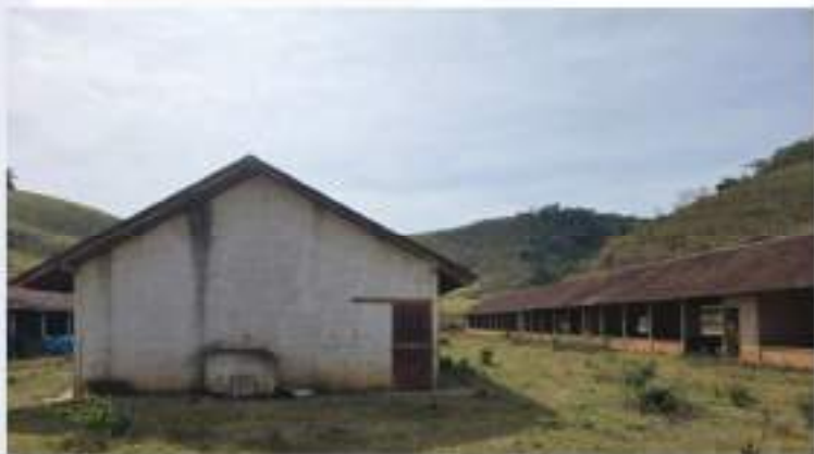
Figura 28 - Fachada - engorda. Fonte: Do autor.
