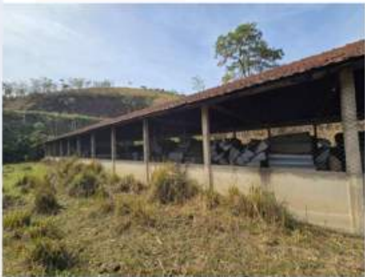
Figura 18 - Lateral do galpão de reprodução de suínos. Fonte: Do autor.
