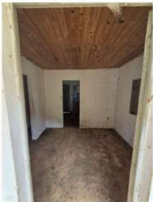
Figura 15 - Identificação do estado de conservação das casas. Fonte: Do autor.
