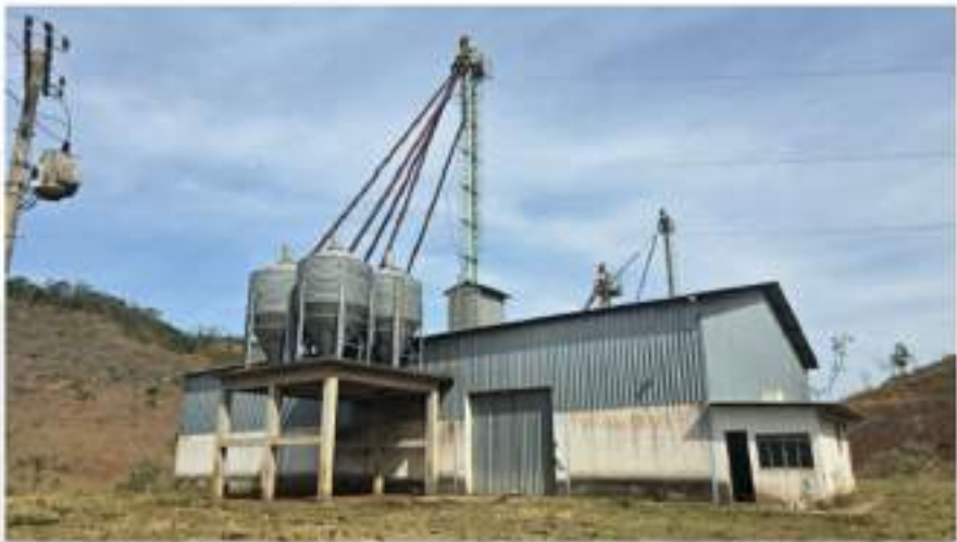
Figura 2 - Vista externa da fábrica de ração. Fonte: Do autor.
