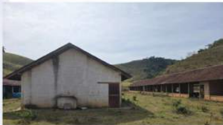
Figura 28 - Fachada - engorda. Fonte: Do autor.
