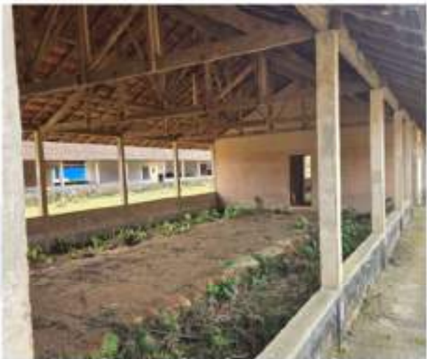
Figura 27 - Estado de conservação - creche, fonte: Do autor.
