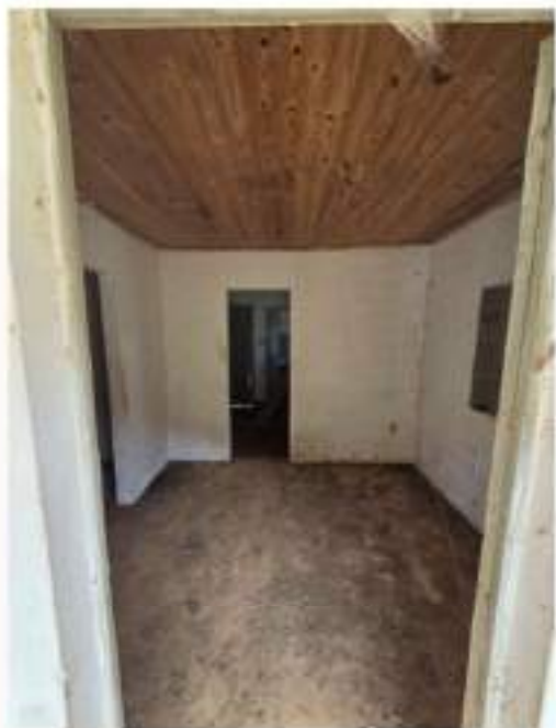
Figura 15 - Identificação do estado de conservação das casas. Fonte: Do autor.
