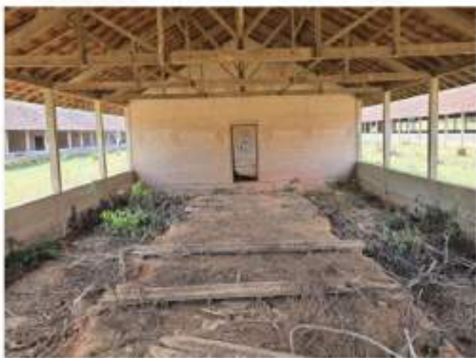
Figura 24 - Galpão de cobrição, Fonte: Do autor.
