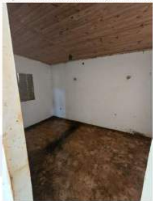
Figura 16 - Interior de uma das casas. fonte: DO autor.
