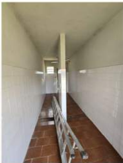
Figura 8 - Vista da sala de descontaminação corporal. Fonte: Do autor.
