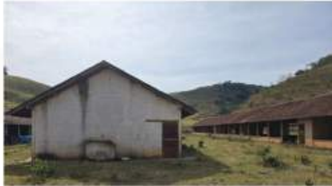
Figura 25 - Fachada - galpão de creche. Fonte: Do autor.
