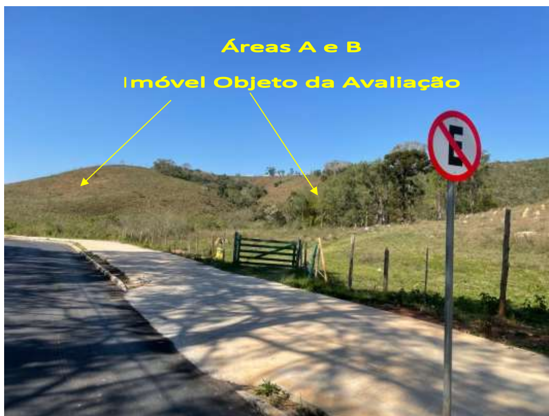
Figura 12 - Acesso às áreas "A" e "B".
