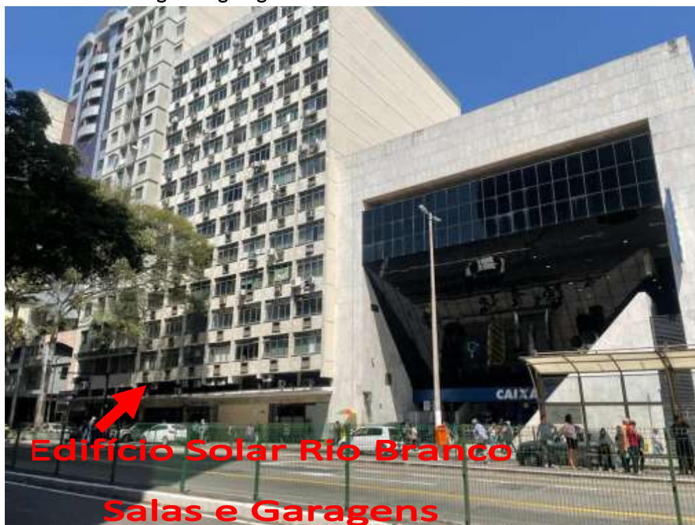
Figura 5 – Fachada do Edifício Solar Rio Branco.
