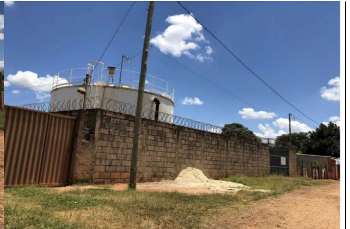
Reservatório da Copasa - Rua das Orquídeas
