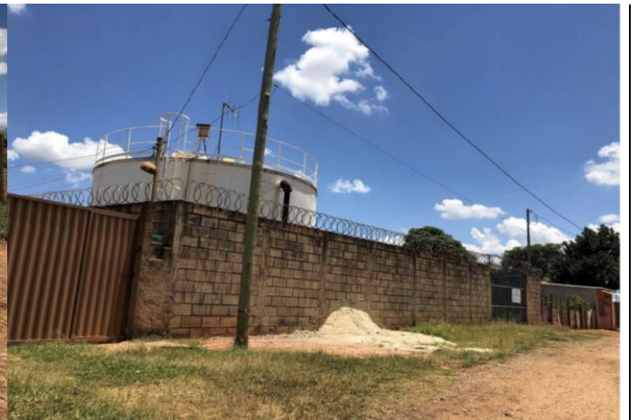
Reservatório da Copasa - Rua das Orquídeas
