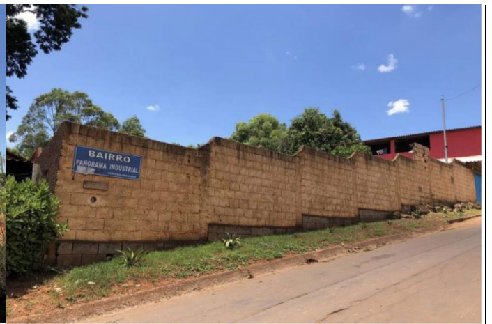
Identificação do Bairro - Rua das Rosas
