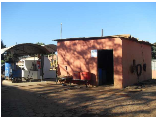
Casa de lubrificantes e bomba
