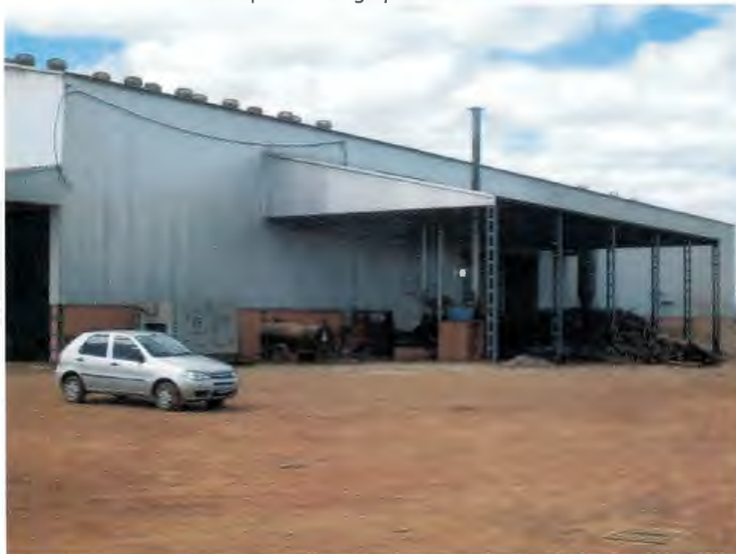
Vista parcial do galpão de secadores
