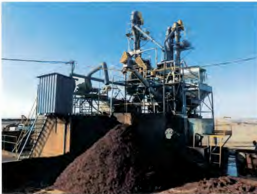
Vista parcial da infra estrutura
