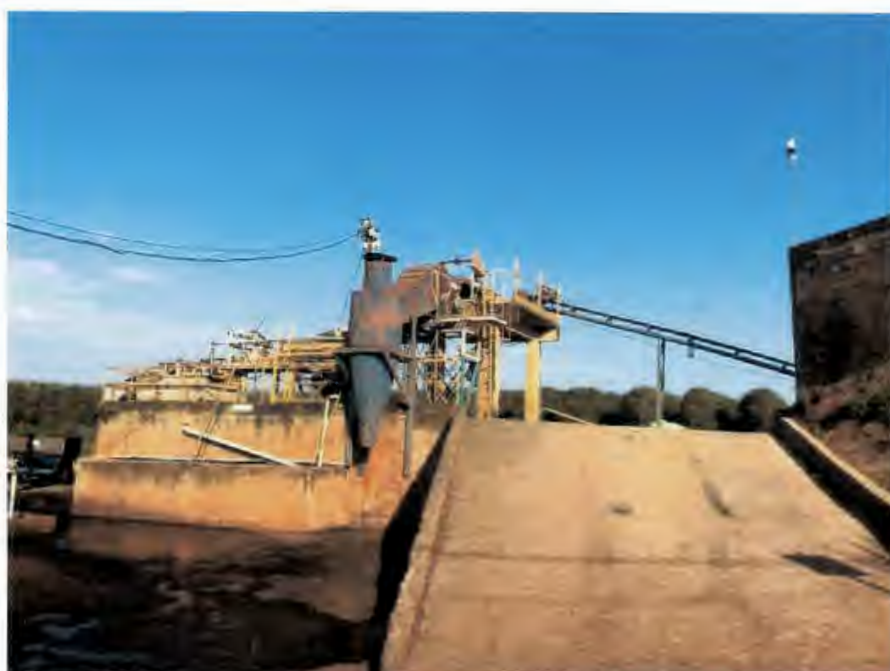
Vista parcial da infra estrutura
