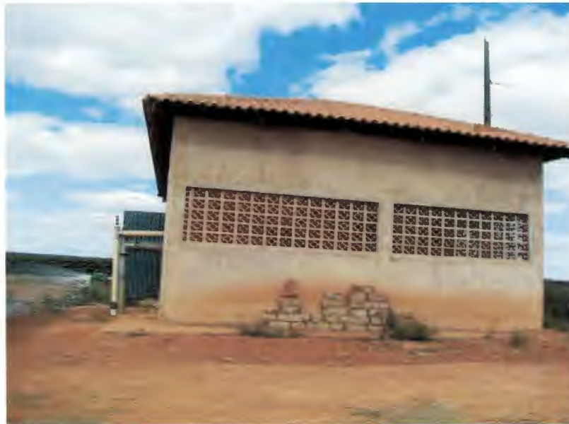
Casa de fertirrigação
