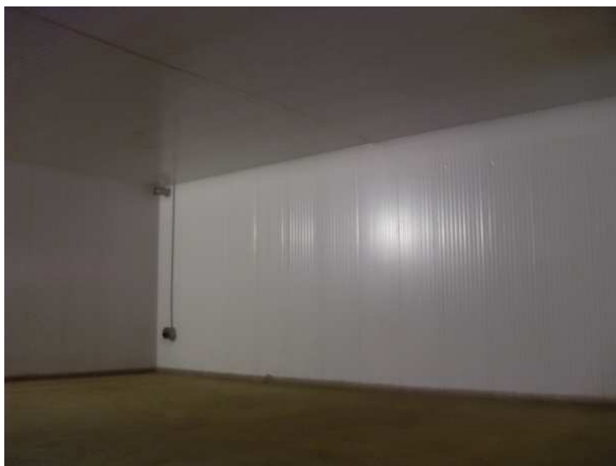
Galpão de câmaras frias – Vista interna e externa
