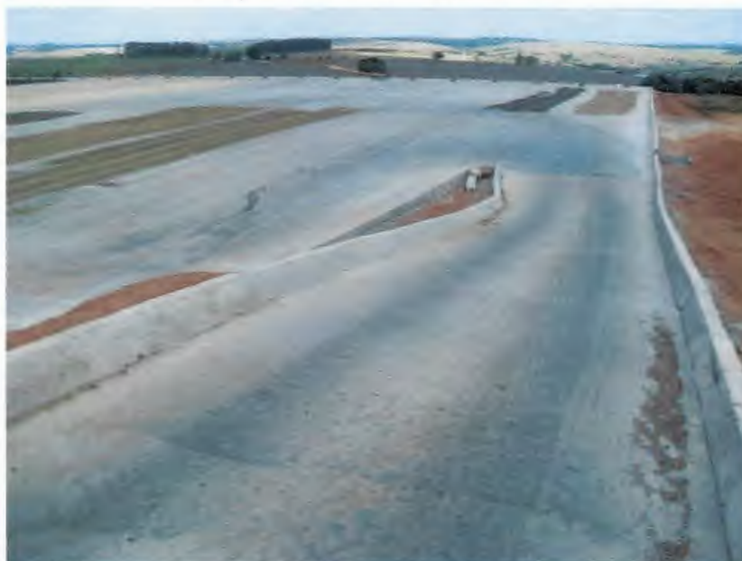
Vista parcial do terreiro novo de café
