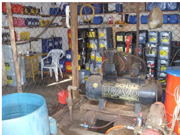
Vista int. da casa de lubrificantes
