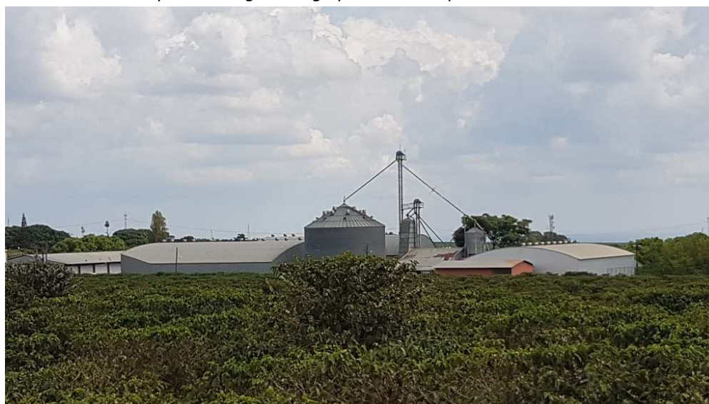
Vista parcial da gleba e galpões fora do perímetro do terreno
